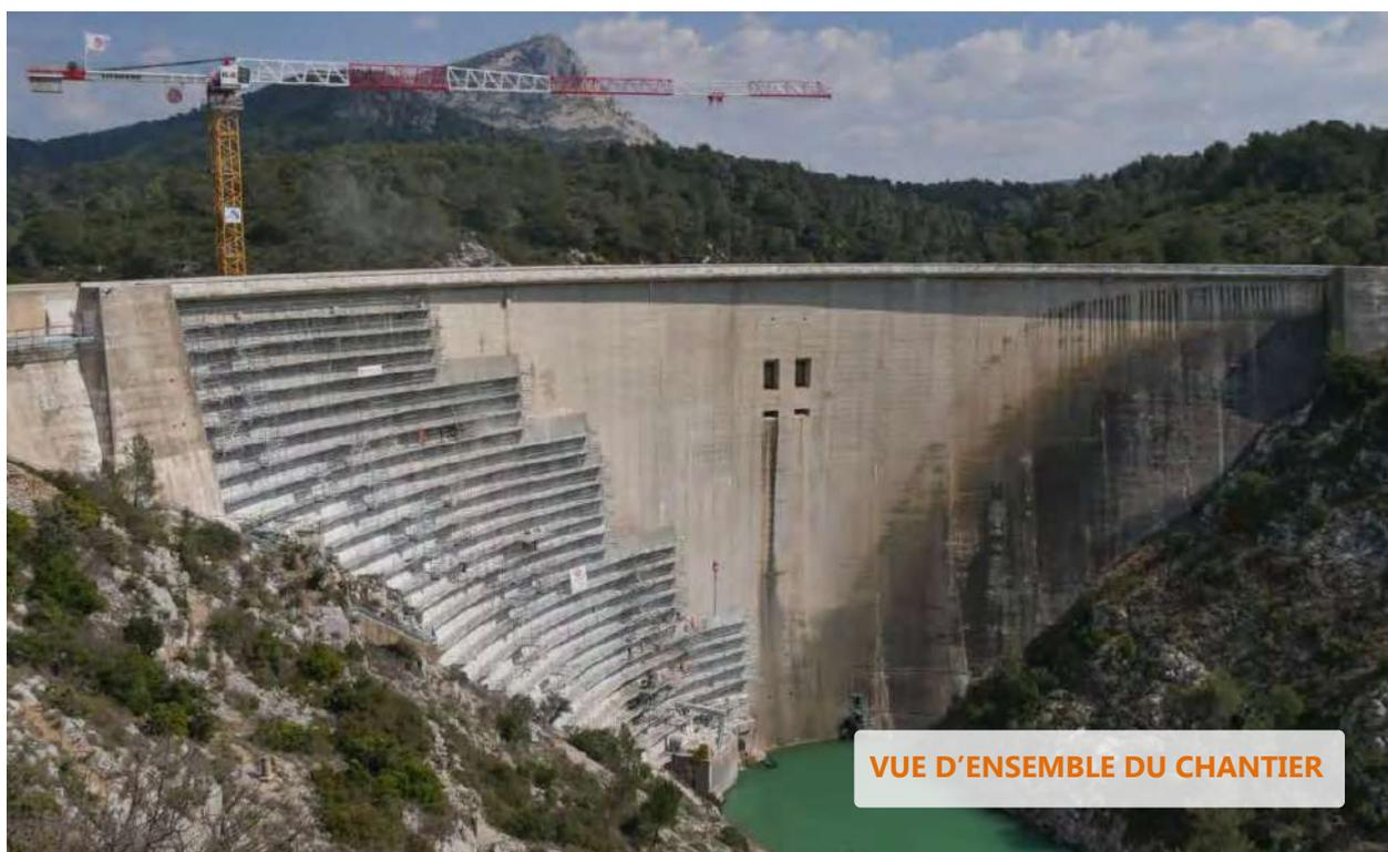
Les travaux sur la voûte vont également être mis à profit pour rénover les organes de vidanges du barrage (changement des vannes de régulation des deux vidanges – principale et secondaire, rénovation des vannes de l'évacuateur de crues), ainsi que l'ensemble des équipements électriques présents sur le site (câblages, automatismes) qui permettent d'exploiter et de surveiller le barrage. Le montant de ce chantier s'élève à 2,2 M€.
