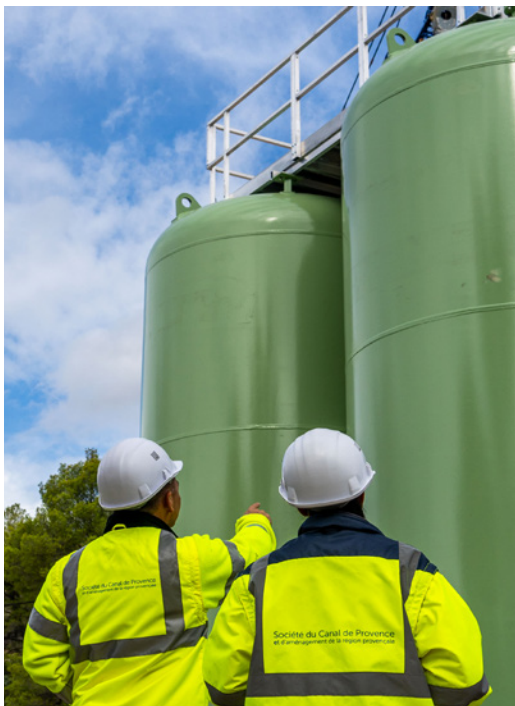
Visite du chantier de modernisation de la de la station de pompage de Pradelles
