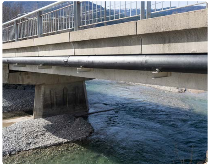
Mesure environnementale (chiroptères) puis pose de la conduite en encorbellement sous le pont routier de Valbelle
