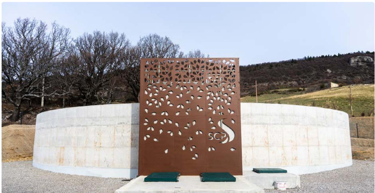
Réservoir du « Bois de Bûche » finalisé
