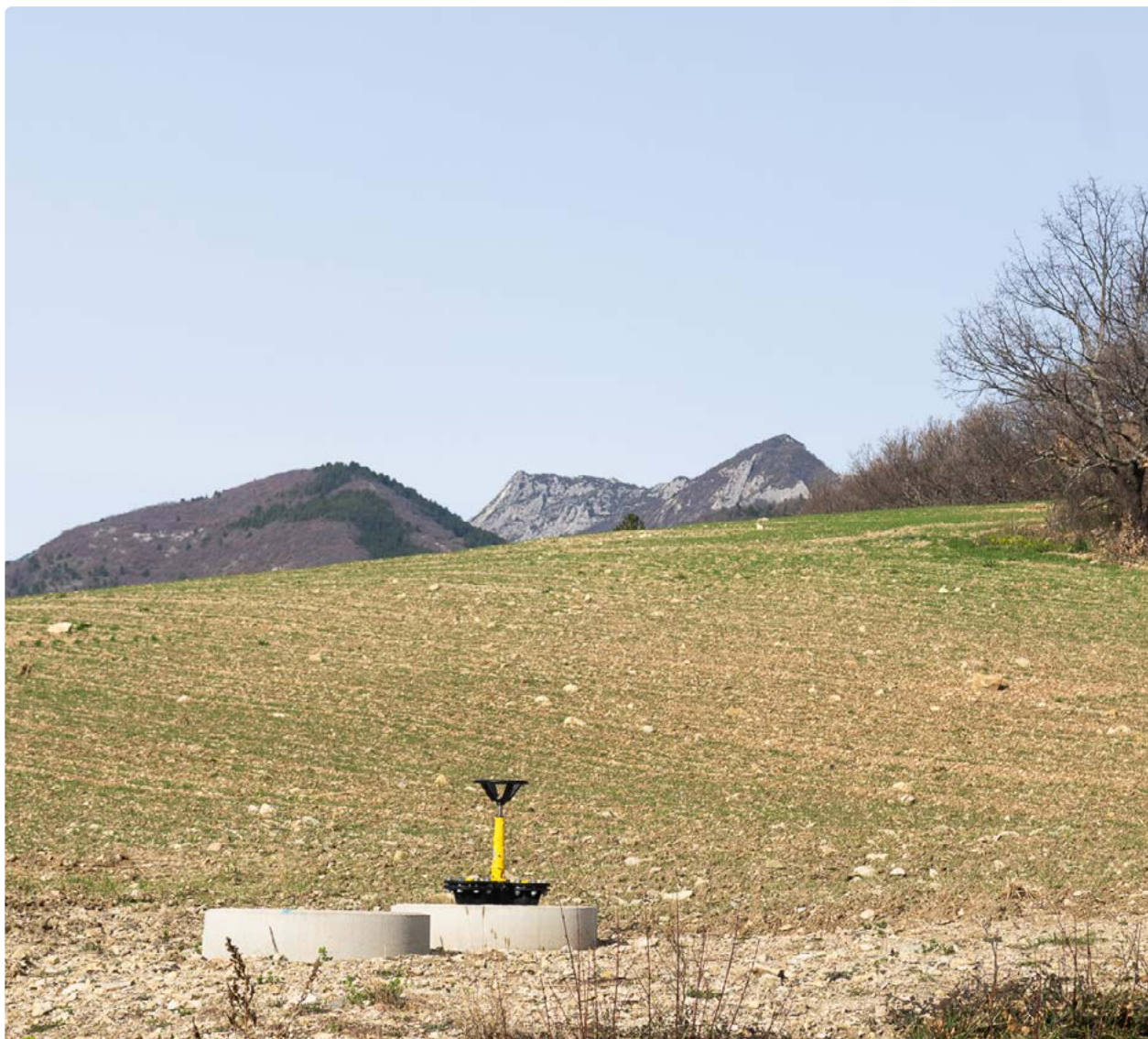
Exemple de borne destinée à l'irrigation
