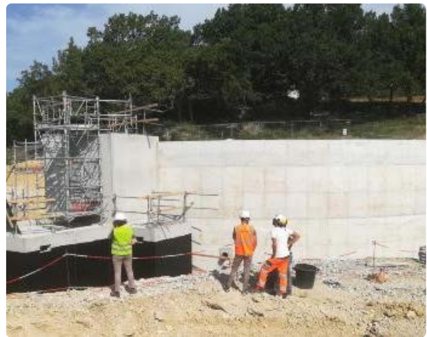
Vue du réservoir pendant les travaux
