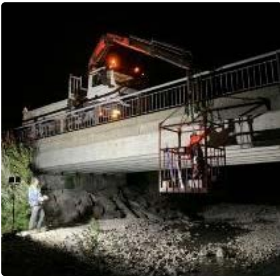
Mesure environnementale (chiroptères) puis pose de la conduite en encorbellement sous le pont routier de Valbelle
