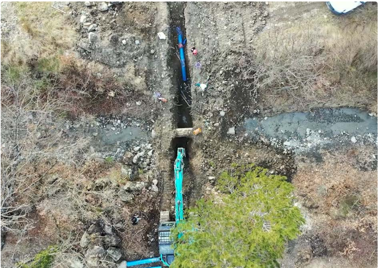
Traversée de cours d'eau
