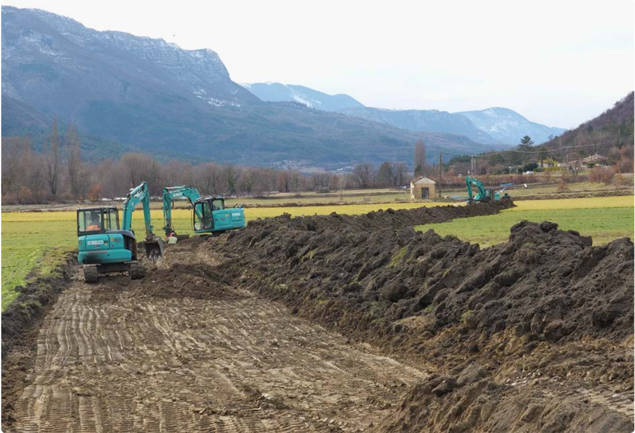
Travaux de tri des terres, ouverture, pose et remblaiement sur le réseau
