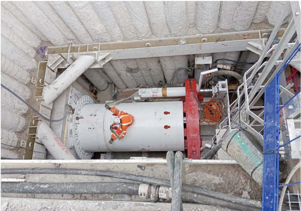
*Mise en place du microtunnelier dans la fosse d'attaque du rond-point dit « des Ruches » de Plan de Campagne*
