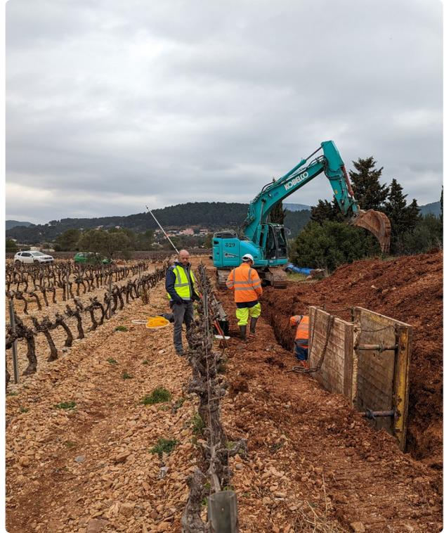
Tranchée ouverte pour pose des réseaux hydrauliques
