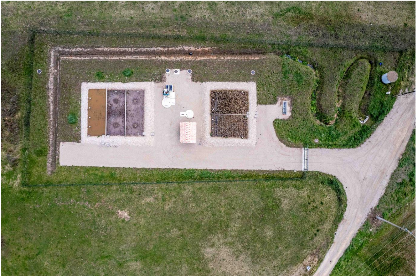
STEP de La Mourotte à La Verdière - Station d'épuration avec filtres plantés de roseaux et fossé de finition – Crédit : David Tatin
