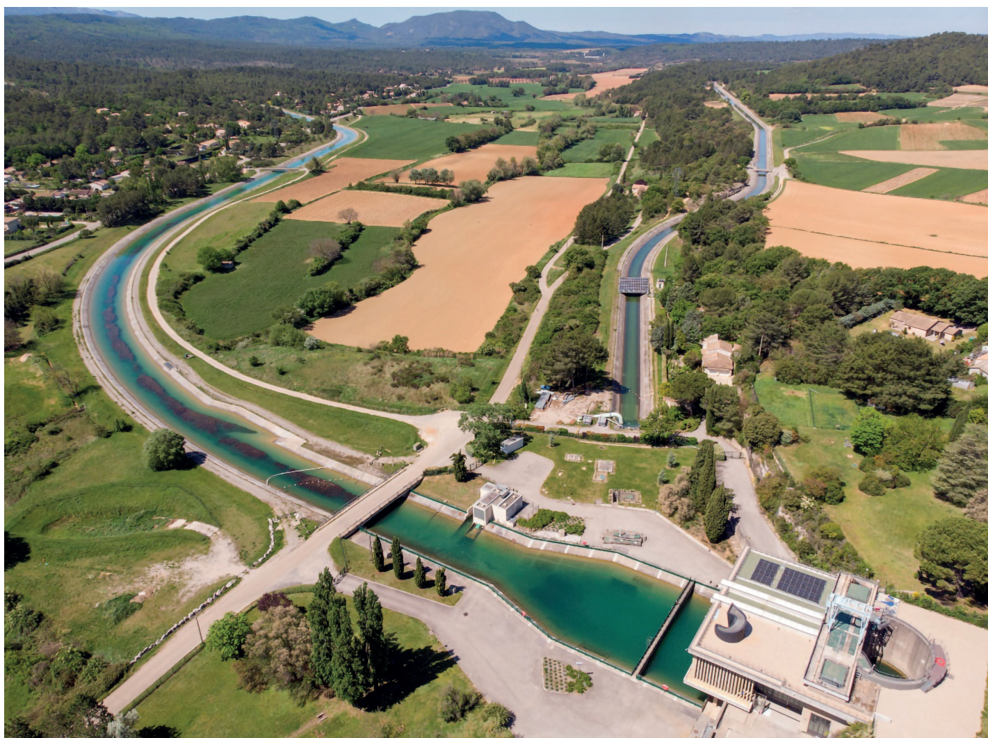
Le Centre de l'Eau et des Énergies de Rians
